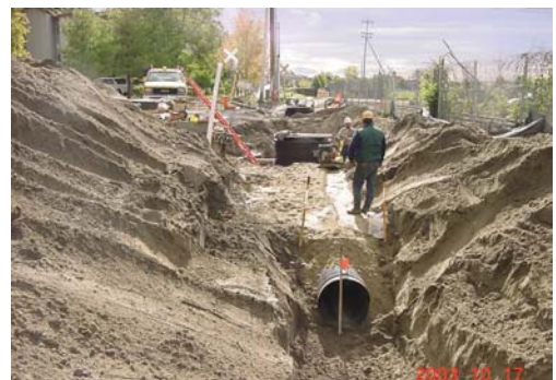
New 24" PE Outfall
